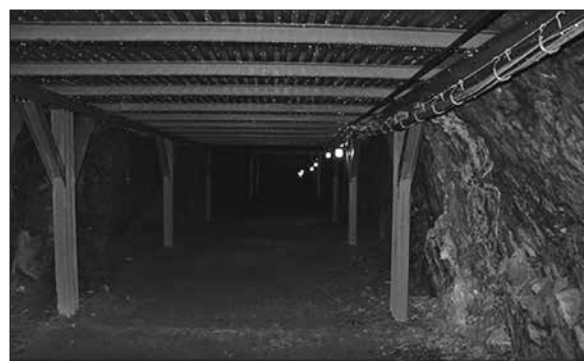
坑道内部 鉄骨で補強されている場所もある
