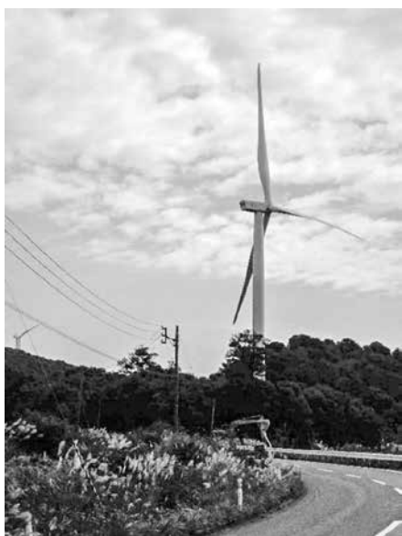
建設工事中の風車（石倉展望場付近）
