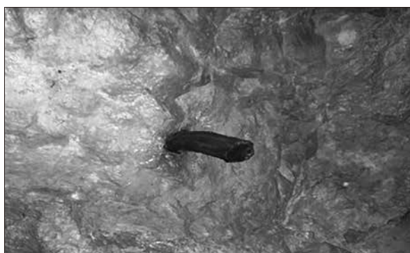
木片 電気配線のため設置利用
