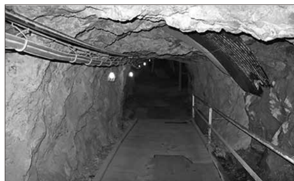
入口付近 下り坂となっている
