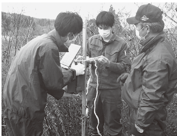
図6 B農場の防護柵設置
