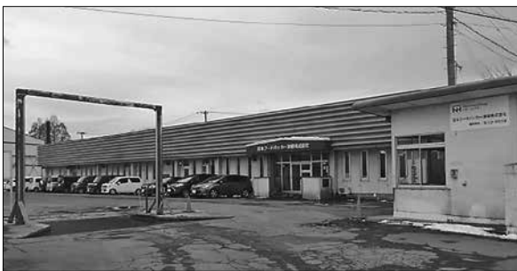
日本フードパッカー津軽 管理棟
