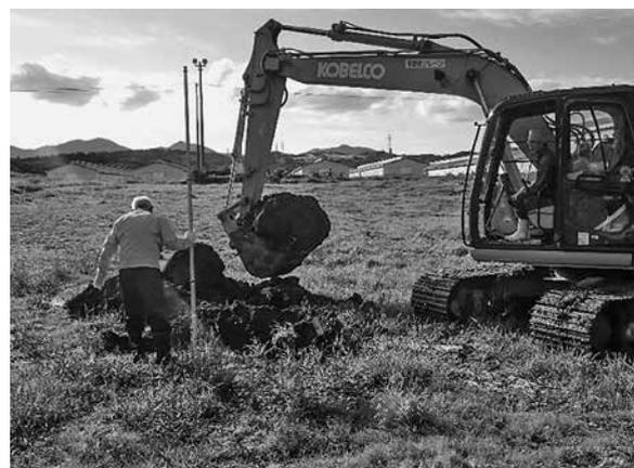
図8 埋却候補地の試掘
